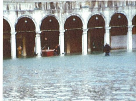
高潮（アックアアルタ）時の被害状況
