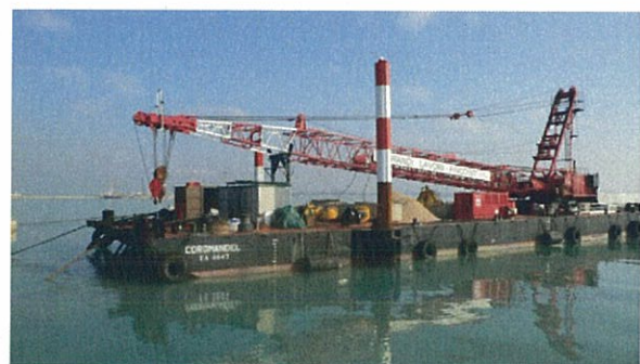
工事が進んでいるリドの現場
