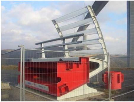
鋼箱桁端部の部材
